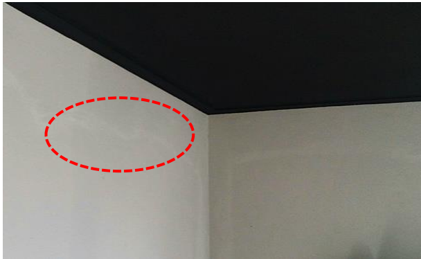
① 도장 오염 날씨에 영향 받아 도장 오염, 넓은 면적에 도장된 색상의 차이 발생
